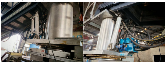
图 13 船载栈桥变幅液压缸轴承座实物安装图
